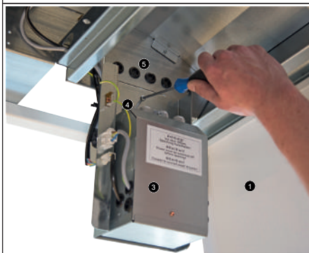
Рис. 15: Отвинтить предохранительный винт
