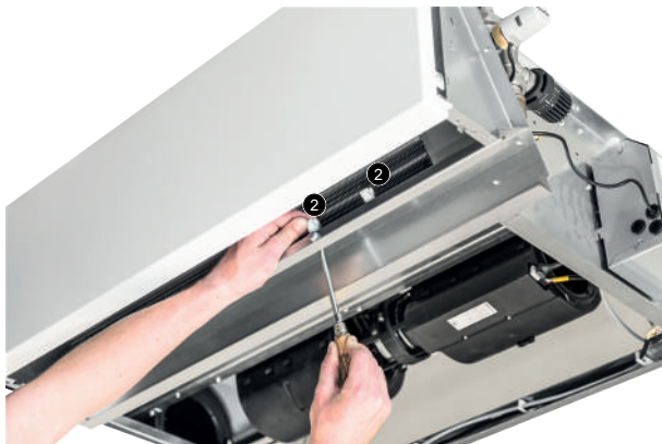
Рис. 18: Смонтировать зажим для трубы ② .
