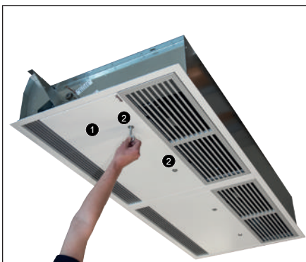
Рис. 13: Открыть ревизионную крышку прибора Tandem в потолочном исполнении
