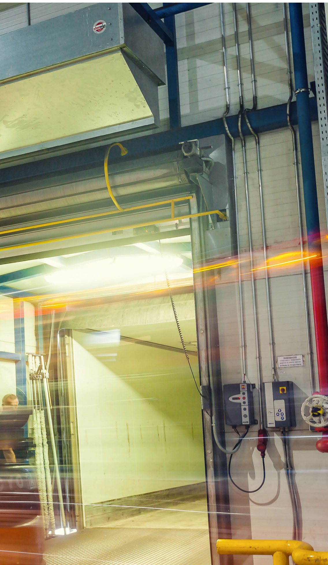
Воздушные завесы ProtecTor препятствуют проникновению холодного воздуха в зону погрузки на предприятии «Волга» — филиал компании Heineken — в Нижнем Новгороде, в сердце России.
