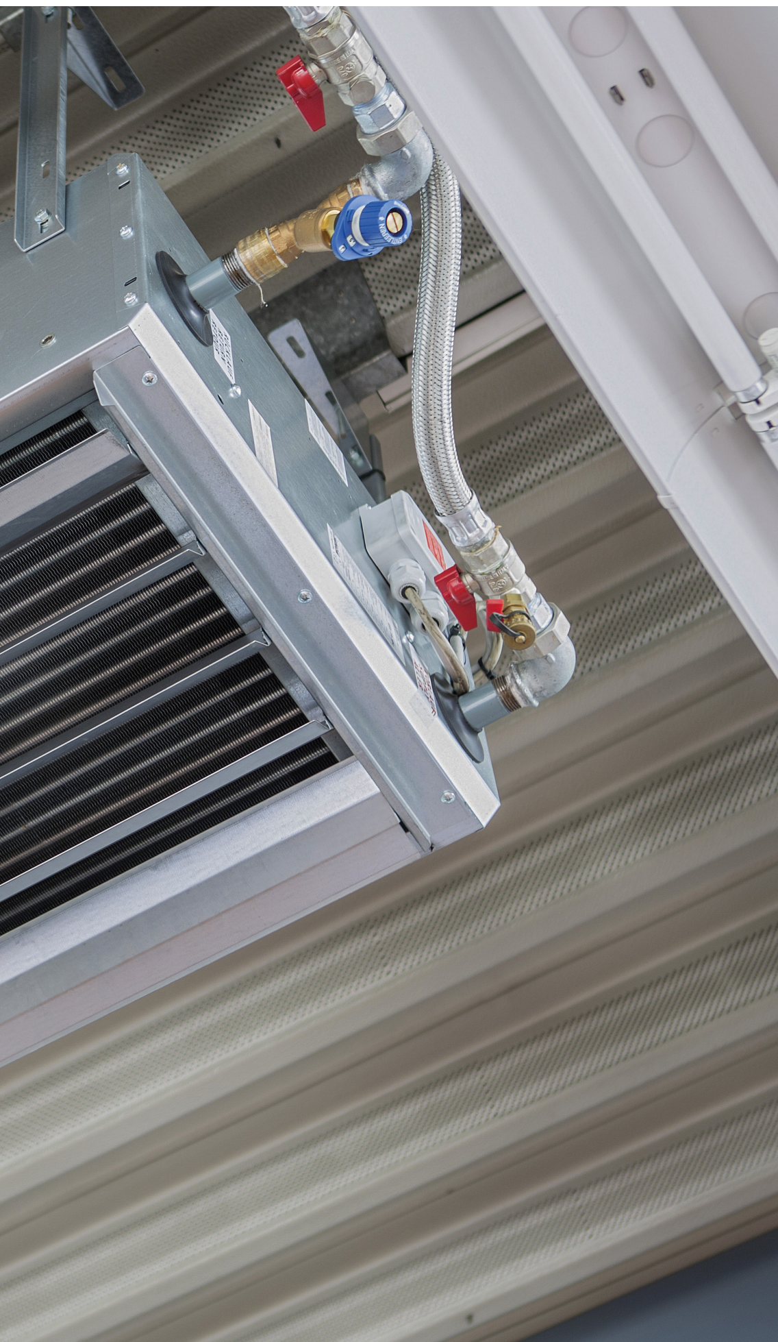
Установленные на потолках тепловентиляторы ТИР обогревают демонстрационный зал автомобильного салона Seyfarth в г. Гота
