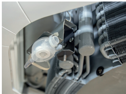
Крепление поплавкового переключателя
