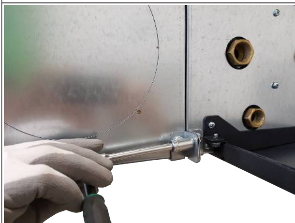
Рис. 11: Затянуть внешние болты
