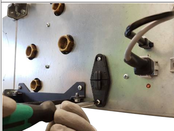
Рис. 21: Монтаж крепления для насоса
