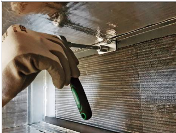
Рис. 13: Затянуть внутренние болты
