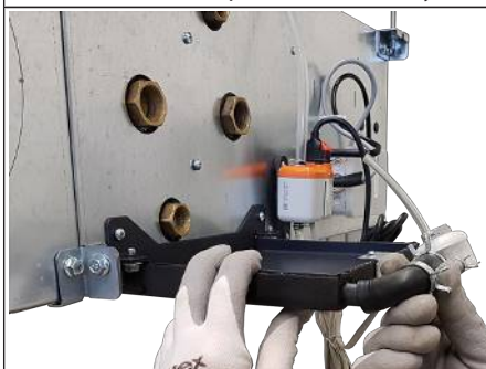
Рис. 59: Отсоединить угловую муфту
