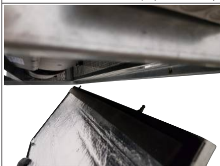
Рис. 53: Вставить ревизионную крышку
